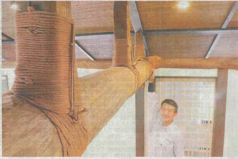
祇園祭の鉾建ての伝統技術「縄がらみ」を生かした耐震補強。縄は京組紐を使う(7日、亀岡市、沙桜里庵)
